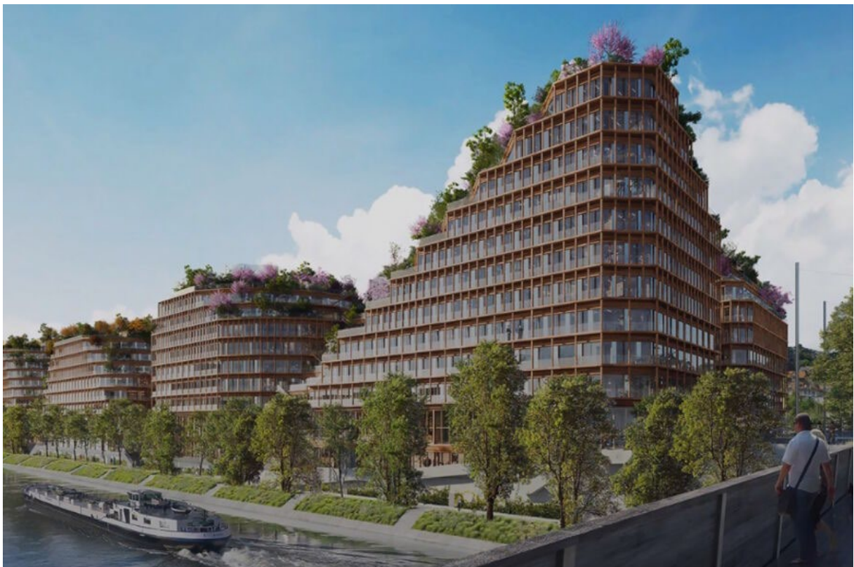
Face Boulogne du projet Bouygues avant modifications demandées. Au premier plan à l'angle, bâtiment B1.
