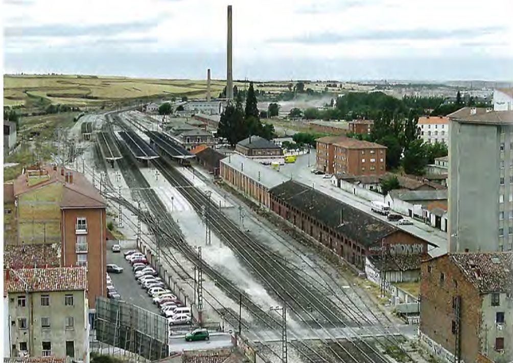
Estado original Original state
