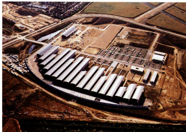
luchtfoto werf aerial photo of construction site
