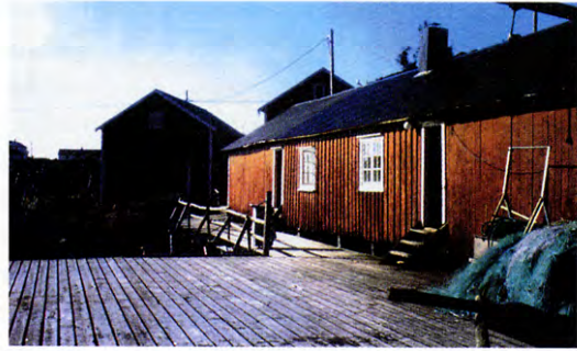
referentiebeeld: constructie op pontons in Noorwegen reference picture: pier construction in Norway
