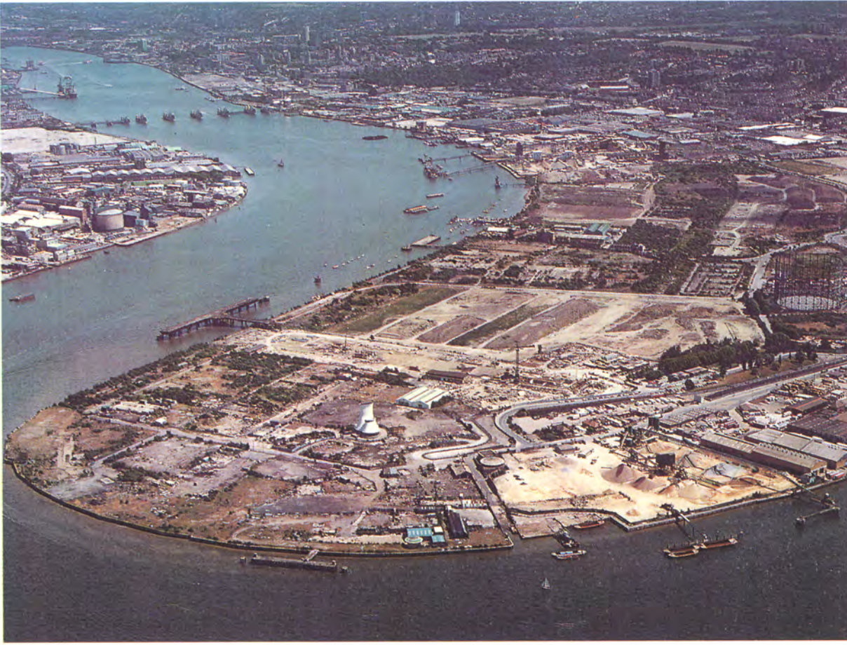
Vue aérienne du site, après démolition des installations industrielles.
