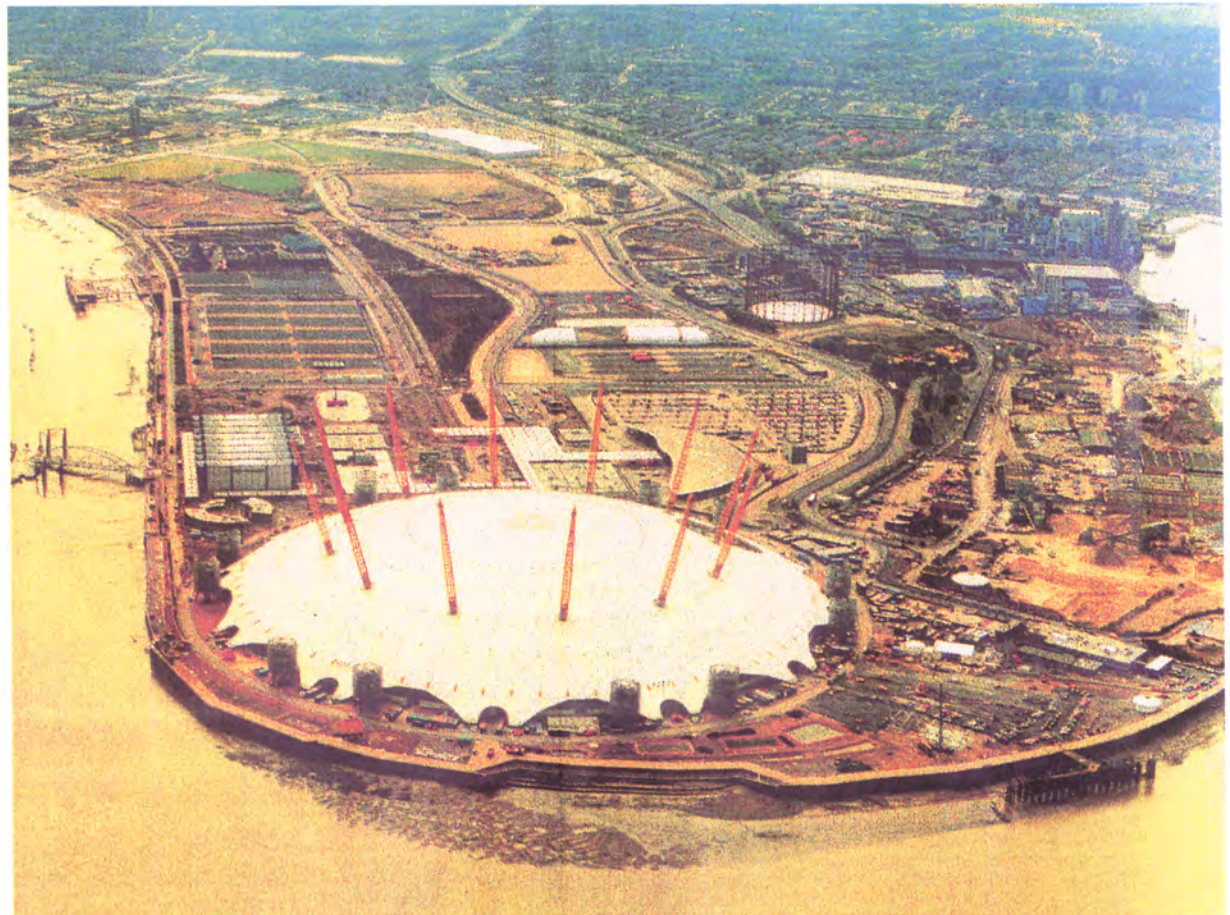
Vue aérienne de Greenwich Peninsula. Le Millenium Dome est déjà réalisé, alors que la construction des résidences est toujours en cours.
