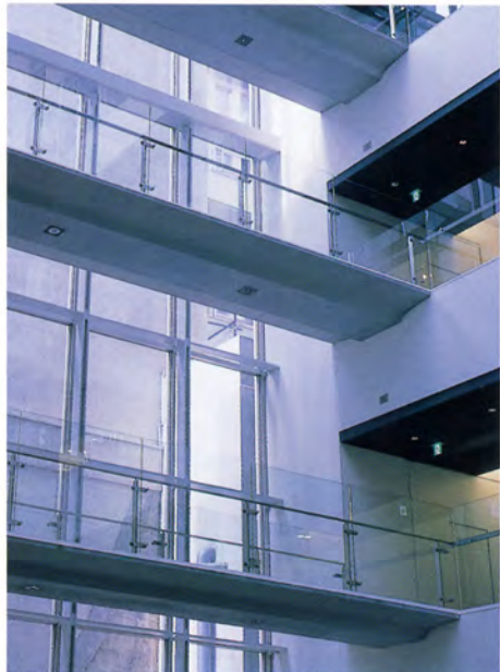
アトリウムのブリッジには超高強度繊維補強コンクリート素材「ダクトアル」が用いられ、12mスパンを50~225mm厚のコンクリート部材で繋いでいる。
