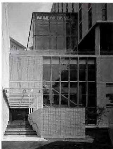
西側の道路へ繋がる地下2階レベルのストリートエントランス。
