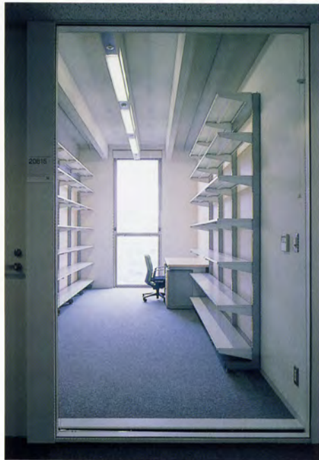
高層部、教員用個室と廊下は床下にブラインドを内蔵したガラスパーティションにより隔てられている。
