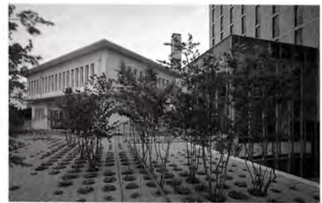
屋上庭園より「萬來舎」、アトリウムおよび高層部を見る。
