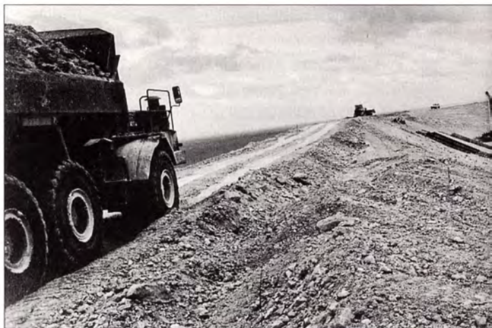
Sangatte-Fonds Pignon. Site de stockage des craies du tunnel.
