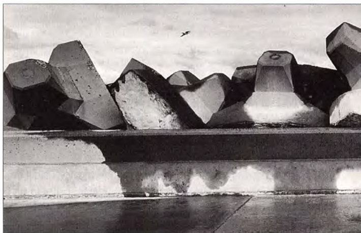
Calais, digue du nouveau port. Photographies effectuées en 1989 dans le
